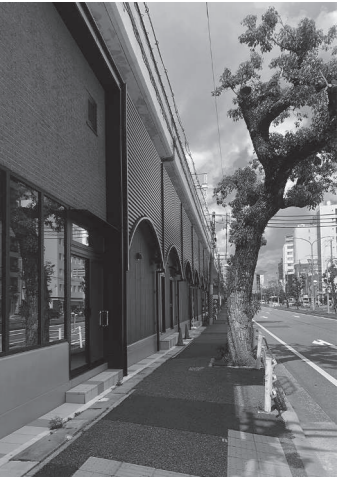
新しいモトコーの外観
