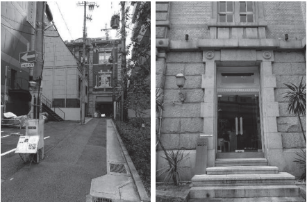
アリアンスタグラフィック 海岸ビルヂング正面
