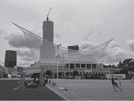
海洋博物館と改修中のポートタワー
