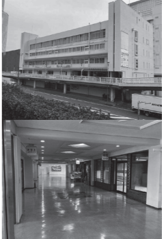
中突堤中央ビル(上写真) 2階飲食店街 (下写真)
