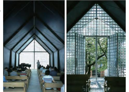
落としながら、祈りの場にふさわしい空間を目指しました。傾斜地の半地階は鉄筋コンクリート造の集会室、上階の礼拝堂は、壁と屋根を一体的に9mmと16mm厚の鉄板の加工部材を組み合わせたシンプルな構成としました。家型の片側の屋根と壁をへの字型の鉄板パーツとし、車両で運搬可能なサイズに分けて工場で作成。現地で組み合わせることで建設コストを抑え、外側を遮熱塗料で仕上げ、自然光や自然換気を極力取り入れながら、空間を構成しています。
