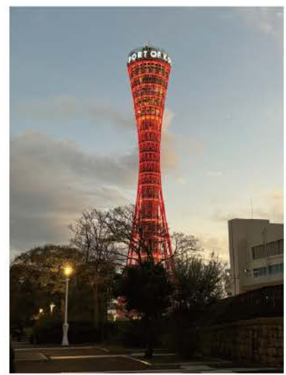
神戸ポートタワー（日建設計工務 1963）
