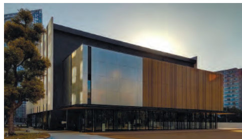
磯上体育館 中央区の市民体育館。室内各競技に対応し地域のスポーツ活動の拠点となっています。
