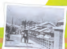
木造跨線橋の相生橋
