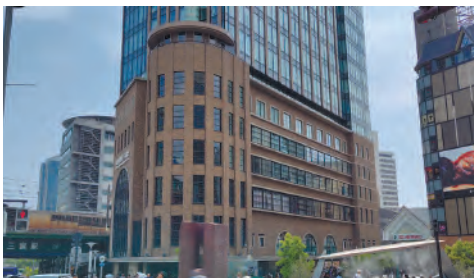
神戸阪急三宮ビル (EKIZO神戸三宮) 三宮の中心に位置する複合商業施設。ビル下部のデザインは震災前の駅ビルをオマージュしています。
